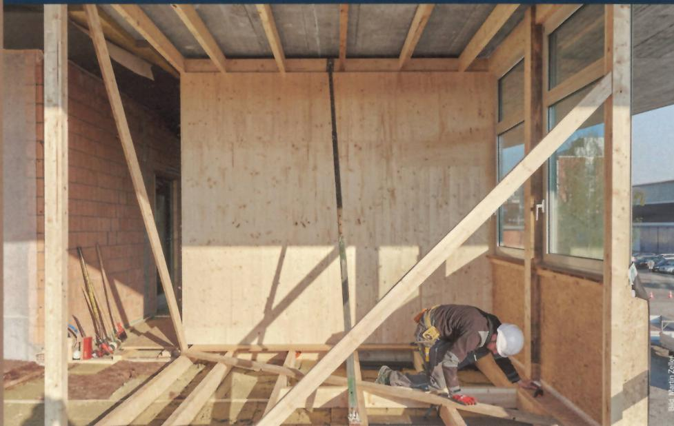
► Für das Bau-Projekt Sprint wurden Module vorgefertigt und dann integriert.
